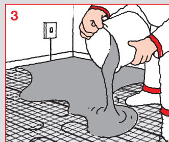
3 Observera att det måste finnas minst 5 mm tjockt skikt av x-plan över kabelns översida för el-kablar och för vattenburna system ska skiktet minst vara en tiondel av rörens avstånd (t.ex. c-avstånd mellan rör 200 mm = 20 mm x-plan över rörens översida). Finjustering kan göras när spacklet kan beträdas med försiktighet (efter 60 – 90 minuter).
