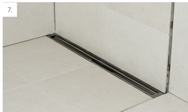
7. Lägg vald Unidrain ram, ClassicLine eller HighLine på plats. Därefter kan golv- och väggplattorna monteras.
