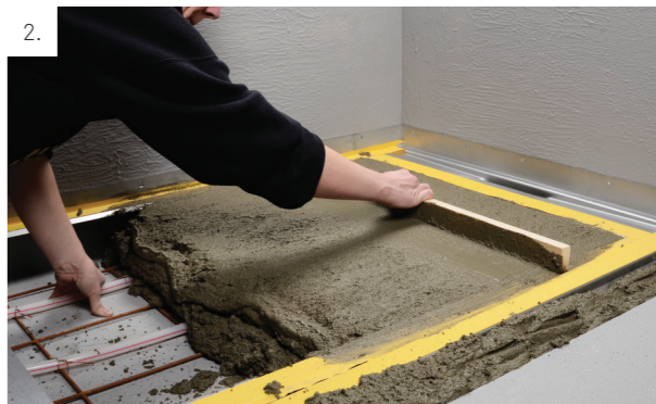
2. Avjämningsmassan eller betongen läggs på i duschplatsen. Avloppsarmaturens inbyggda fall tillsammans med en rätbräda underlättar fallbyggnaden. Därefter kan resten av golvet gjutas upp i nivå med avloppsarmaturens horisontella tätskiktfläns. Ytor för tätskikt skyddas med lämplig bygg / skyddstape.
