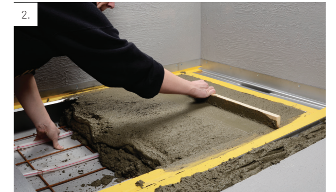
Avjämningsmassan eller betongen läggs på i duschplatsen. Avloppsarmaturens inbyggda fall tillsammans med en rätbräda underlättar fallbyggnaden. Därefter kan resten av golvet gjutas upp i nivå med avloppsarmaturens horisontella tätskiktfläns. Ytor för tätskikt skyddas med lämplig bygg / skyddstape.
