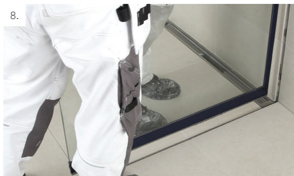
8. Unidrain GlassLine monteras i profilen på vägg och i spåret på ShowerLine armaturen.
