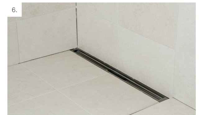
6. Stora golvplattor används med fördel. Snabbare montage och mindre fogningsarbete.
