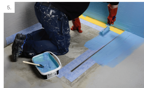
5. Tätskiktet monteras på hela golvet och väggarna enligt tillverkarens anvisningar. Lagg vald Unidrain ram, ClassicLine eller HighLine på plats innan väggplattorna monteras.
