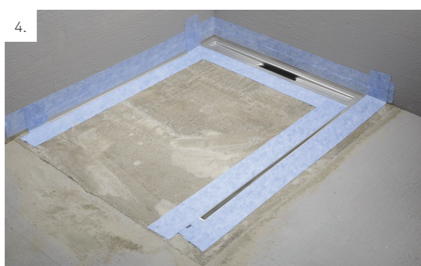
4. Tätskiktet monteras enl tätskiktsleverantörens anvisningar. OBS! Ett systemgodkänt tätskikt av folie eller vätske-baserad typ ska monteras enl gällande branschregler. Monteringsanvisningen för GlassLine duschvägg efterföljs. OBS! Kontakta JAFÖ's kundtjänst för monteringsanvisning. Tel: 046 - 33 39 00
