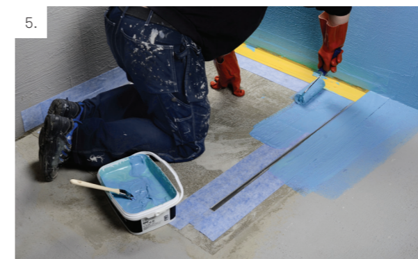
Tätskiktet monteras på hela golvet och väggarna enligt tillverkarens anvisningar.
