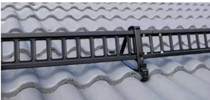
Bild 22. Snörasskydd Safe monterad på tak.
