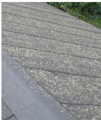
Tak av papp med angrepp av lav. Tre år efter behandling med Grön-Fri. Inget efterarbete.
