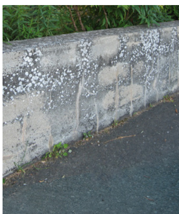
Putsad mur med angrepp av lav behandlad med Grön-Fri. Inget efterarbete. Vänster: Innan behandling. Höger: Fyra år efter behandling.
