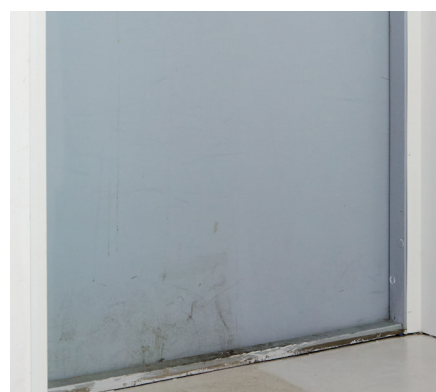
Färdigt för målning utan att ytan behöver sköljas med vatten.
